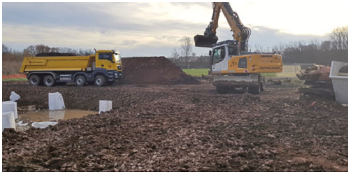
Bereich West: Aushub und Herstellung Rampendammplatte
