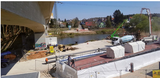
Brücke im Bau, später Einpassung auf die Widerlager
