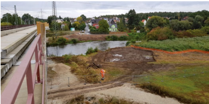
Oberboden West fertig abgezogen
