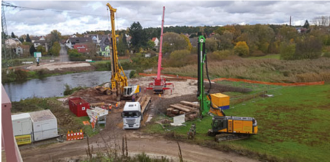
Bereich West: Baugeräte
