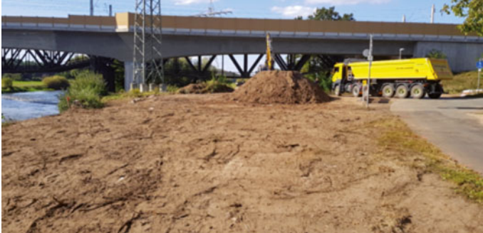
Bereich Brücke Ost, Detail; Abzug Oberboden [Baubereich] fertig, Wurzelstöcke entfernt, HW O-Ob01 im Hintergrund
