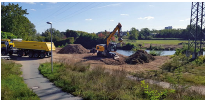
Bereich Brücke Ost, Abzug Oberboden [Baubereich] fertig, Wurzelstöcke entfernt, Grünschnittverladung
