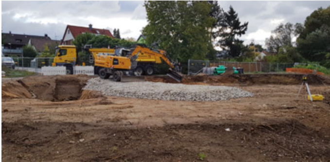
Bereich Ost: Einbau Schroppen für Bohrplanum
