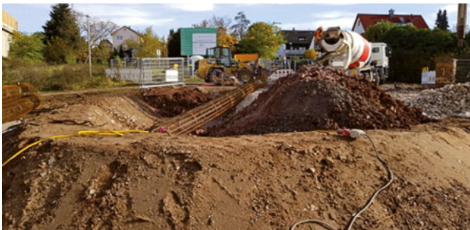
Bereich Ost: Durchführung Bohrpfähle
